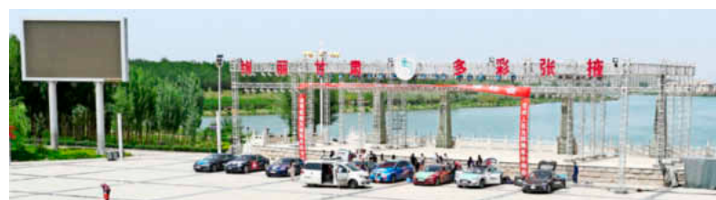
Imposant: In China wurden Ladestationen zum gemeinsamen Laden eingerichtet. Wegen Überlastung gab es einmal einen Kabelbrand.
